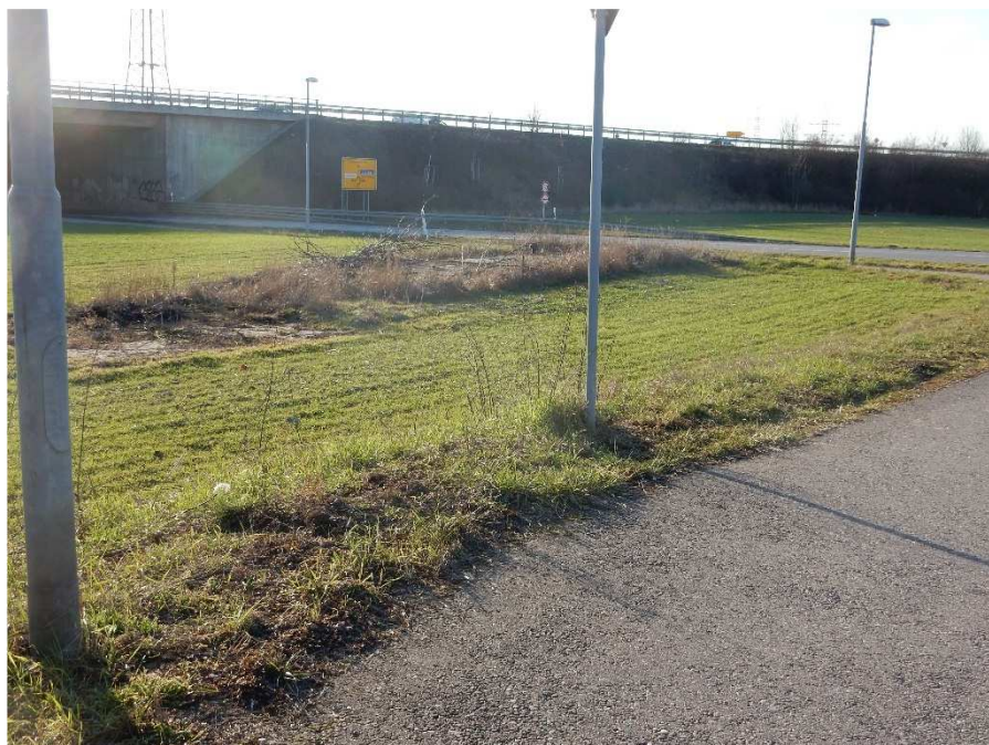
Foto 12: mit Ruderalflur über- wachsenes unterirdi- sches Bauwerk
